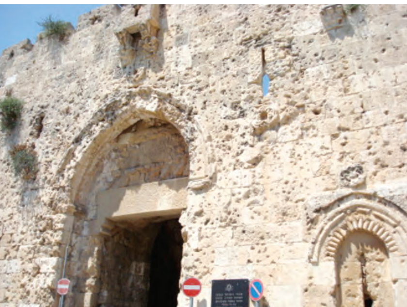
耶路撒冷老城布满弹孔的城墙。
